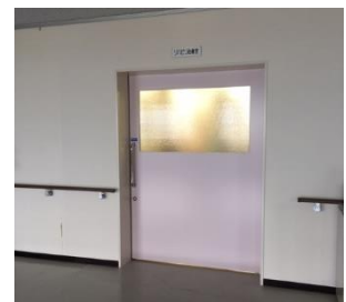
4階リハビリ室の入口ドアがスライド式に改修工事
